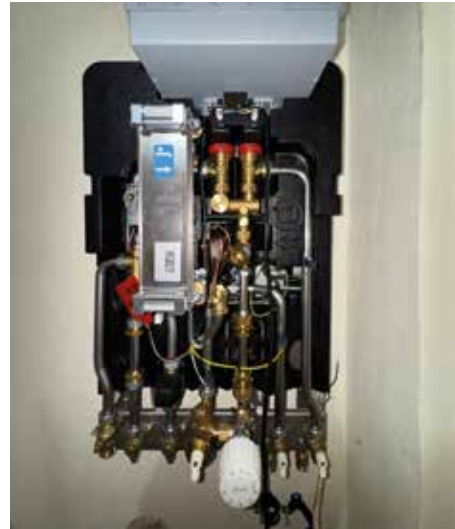
Heizungsmodernisierung in der Keplerstraße 39-43
